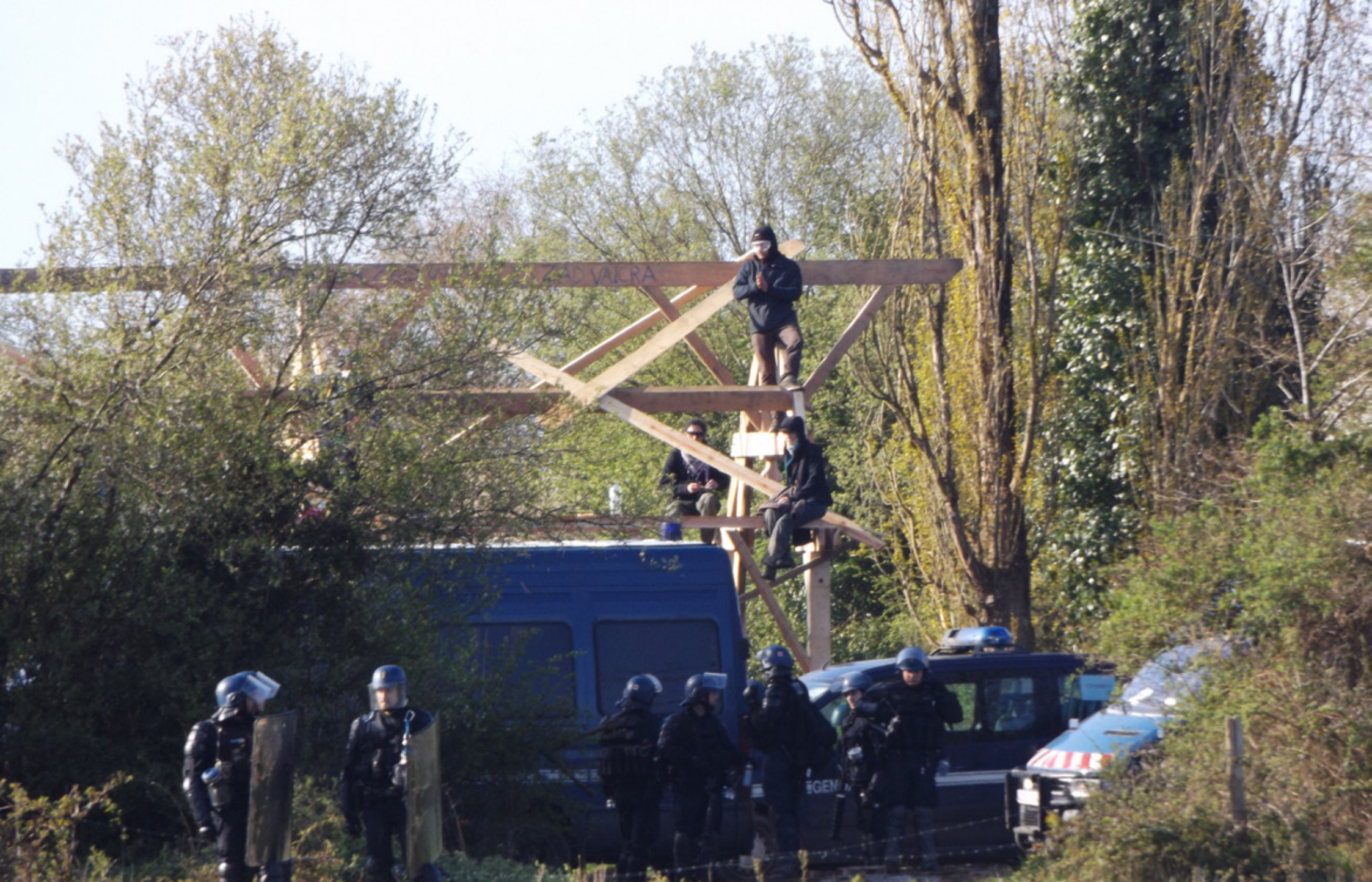
Ils ont d'abord été obligés de monter sur la maison pour en déloger quelques résistant-e-s. Puis des hommes cagoulés ont tronçonné les pieds du Gourbi mobile avant qu'un tank n'achève le travail en venant écraser le tout.
